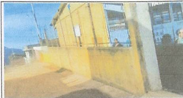
Foto 2: PICADO, CERNIDO Y PINTADO EN MURO EXTERIOR E INTERIOR PARED DE CALLE.
