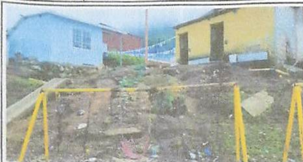
Foto 1: LEVANTADO DE MURO DE CONTENCIÓN, APLICACIÓN DE SABIETA DE MURO DE CONTENCIÓN Y GRADA.
