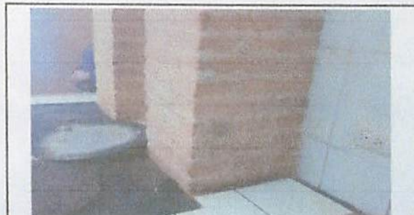
Foto 6: REPARACIÓN DE CHIMENEA PARA MEJOR CALENTAMIENTO DE PLANCHA
