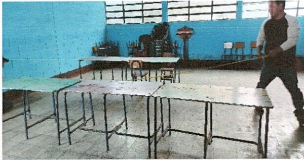
Foto1: Medidas para sustitución de piso de granito por piso antideslizante
