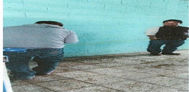
Foto 2: Medidas para sustitución de piso de granito por piso antideslizante
