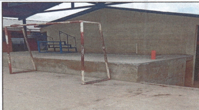
Foto 2: Culminación del Mejoramiento de Sistema de Distribución de Agua Potable con La Implementación de una Cisterna (2.55 x 3 x 1.75 metros)
