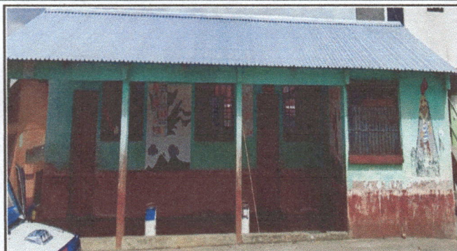
Foto1: Finalización Cubierta de Lámina, sustitución de lámina por lámina troquelada aluzinc calibre 26, sustitución de capote de lámina por lámina troquelada, sustitución de elementos de fijación( 8.5 x 16.5 metros)
