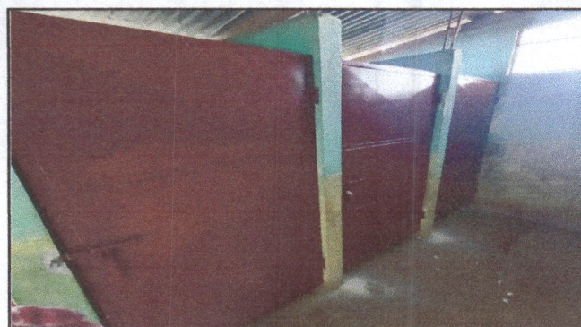
Foto 4: Culminación de Sustitución de Puerta (80 x 150 centímetros)
