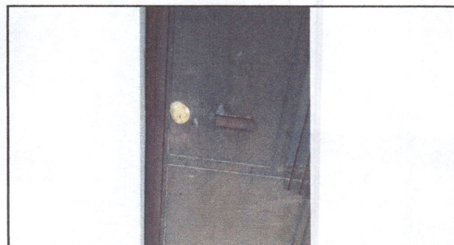
Foto 6: Terminación de colocación de Chapa (Yale)
