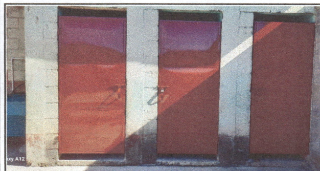
Foto 5: Finalización Sustitución de Puerta ( 0.65 x 2 metros)
