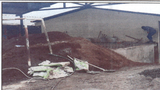
Foto 2: Mejoramiento de Sistema de Distribución de Agua Potable con La Construcción de una Cisterna (2.55 x 3 x 1.75 metros)
