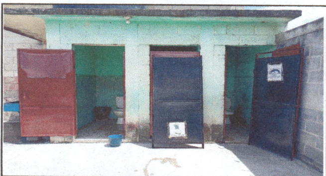
Foto 5: Sustitución de Puerta (0.65 x 2 metros)
