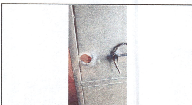
Foto 6: Desmontaje de Chapa (Yale)
