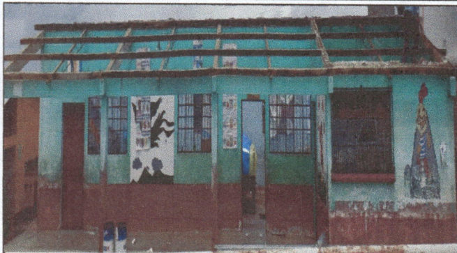
Foto 1: Cubierta de Lámina, colocación de lámina por lámina troquelada aluzinc calibre 26, colocación de capote de lámina por lámina tropelada, colocación de elementos de fijación (8.5 x 16.5 metros)
