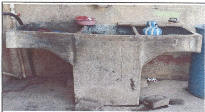
Foto 3: Sustitución de Pila
