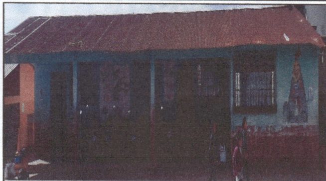
Foto 1: Cubierta de Lámina, sustitución de lámina por lámina troquelada aluzinc calibre 26, sustitución de capote de lámina por lámina troquelada, sustitución de elementos de fijación( 8.5 x 16.5 metros)
