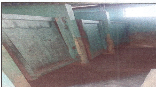
Foto 4: Sustitución de Puerta (80 x 150 centímetros)
