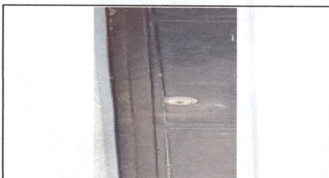
Foto 6: Sustitución de Chapa (Yale)
