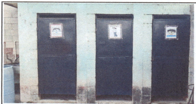
Foto 5: Sustitución de Puerta ( 0.65 x 2 metros)
