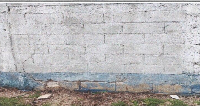
Foto 5: Reparación de pared de muro de contencion
