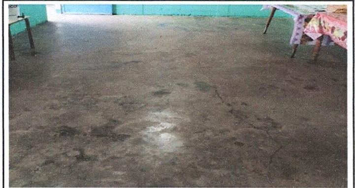
Foto 4: Colocación de piso ceramico
