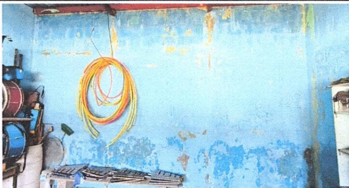
Foto 3: Cambio de pared del tercer salón
