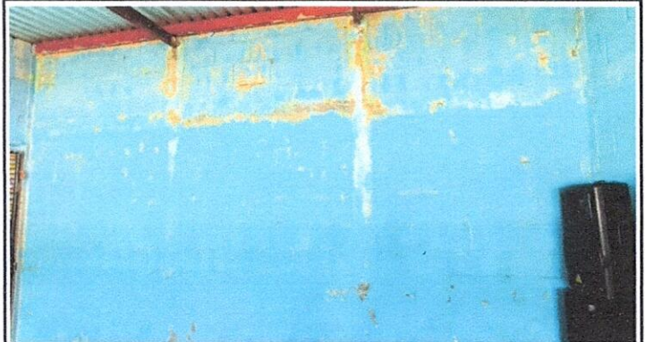
Foto 2: Cambio de pared del segundo salón
