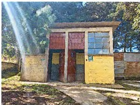
Foto 13: Aplicación de repello en sanitarios, parte exterior
