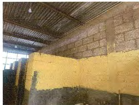
Foto 14: Aplicación de repello en sanitarios, parte interior.
