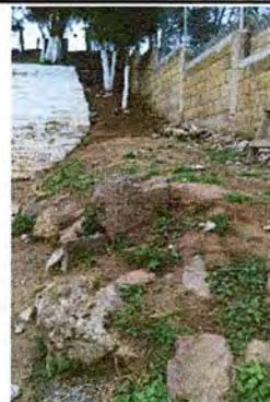
Foto 10: Colocación de plancha de concreto.
