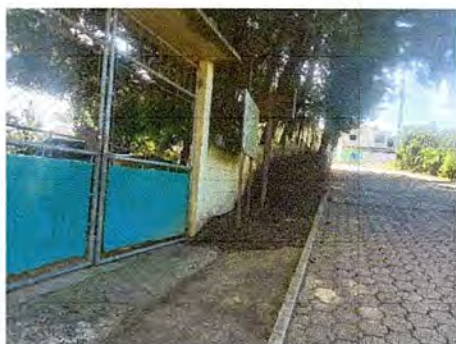
Foto 15: Aplicación de pintura, en circulación, parte frontal.
