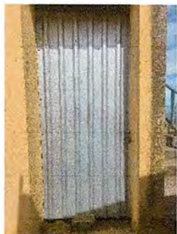
Foto 3: Sustitución de puerta de sanitarios de maestros.
