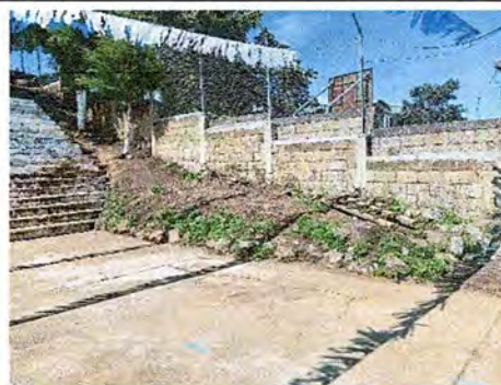
Foto 16: Levantado de muro de contención, 22mts largo por 1 mt alto.
