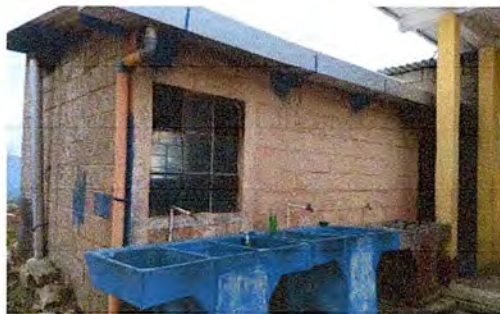
Foto 11: Aplicación de repello en cocina, parte exterior.
