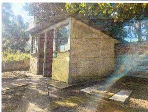
Foto 9: Aplicación de pintura en sanitarios, interior y exterior.
