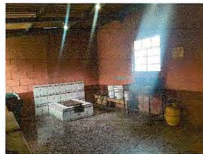
Foto 12: Aplicación de repello en cocina, parte interior.
