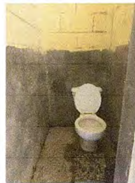
Foto 2: Sustitución de sanitarios y accesorios, área de niñas
