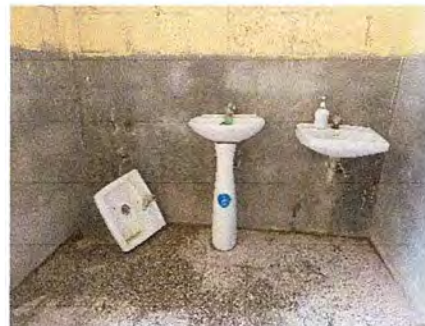
Foto 4: Sustitución de lavamanos y sus accesorios, área de niños.
