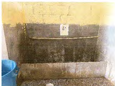
Foto 7: colocación de azulejos en mijitorio.
