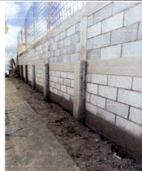
Foto 2: muro con electromalla.
