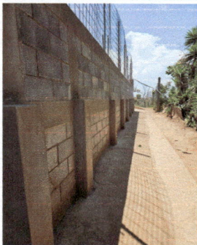
Foto 3: Pared de muro finalizada.
