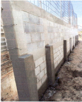
Foto 1: Muro en proceso de finalización.
