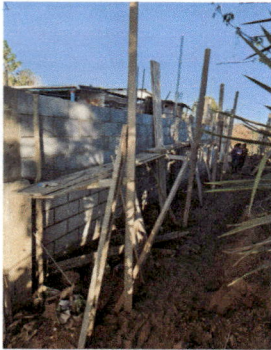
Foto 3: Levantado de la pared del muro.
