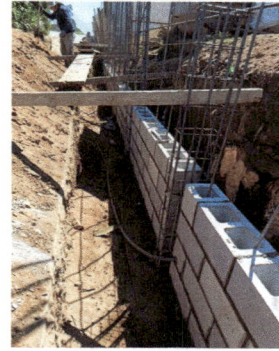
Foto 2: Continuación del muro.
