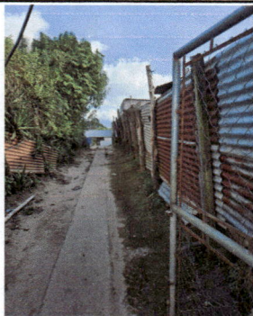
Foto 3: Área a trabajar muro contención para protección
