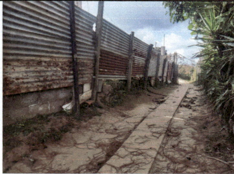
Foto 1: Recubrimiento de talud a través de muro de contención.
