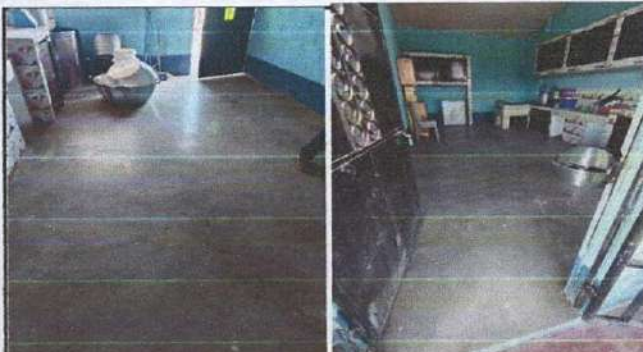
Foto 4: MEJORAMIENTO DE COCINA. SE COLOCARÁ PISO CERAMICO ANTIDESLIZANTE EN LA COCINA. ADEMÁS SE REPINTARÁN LAS PAREDES.
