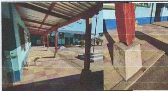
Foto 6: REEMPLAZO DE PILARES EN CORREDOR. SE REEMPLAZARÁN 7 PARALES DE MADERA QUE YA ESTAN MUY DAÑADOS. SE COLOCARÁN PARALES DE METAL.
