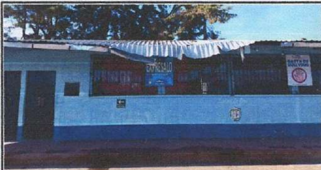
Foto 1: REPARACION DE ESTRUCTURA DE TECHO DAÑADO EN 2 AULAS Y CORREDOR. SE CAMBIARAN LAMINAS, COSTANERAS, CANALES Y CAPOTES DE DOS AULAS QUE FUERON DAÑADAS AL CAERLES UN ARBOL DEBIDO A LAS INCLEMENCIAS DEL TIEMPO
