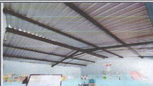
Foto 8: CIELO FALSO SE COLOCARÁ CIELO FALSO A 3 AULAS PARA PROTEGERLAS DE LA ENTRADA DE POLVO, SUCIEDAD Y OTROS.
