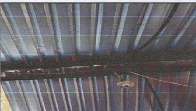
Foto 10: INSTALACION ELECTRICA : SE CAMBIARA EL SISTEMA ELECTRICO DE ILUMINACION (LAMPARAS, APAGADAORES Y TOMACORRIENTES EN AULAS DAÑADAS).
