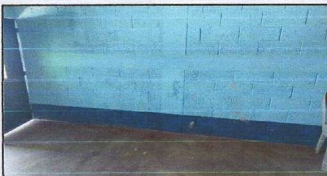
Foto 3: MEJORAMIENTO DE COCINA. PARED DE LA COCINA DONDE SE COLOCARÁ AZUJEJO Y EXTRACTOR DE OLORES
