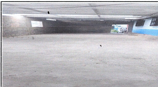
Foto 1: Esta es el área de cocina en donde se hará los trabajos que hace falta para que esté al 100% para que sea utilizado, se construirá 5 planchas, 1 closet de concreto con su puerta corrediza.
