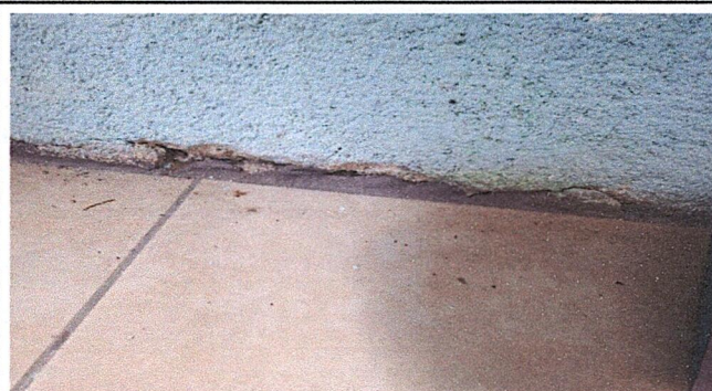
Foto 2: Reparación de repello de pared y cernido
