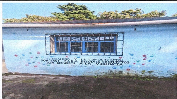
Foto 1: Reparación de repello de pared y cernido
