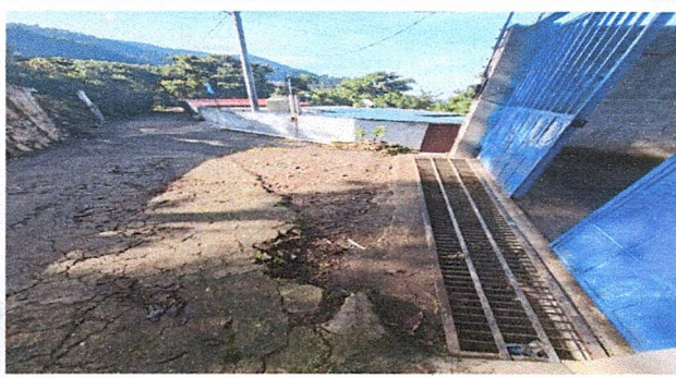
Foto 3: Reparación de la entrada principal parte externa e interna
