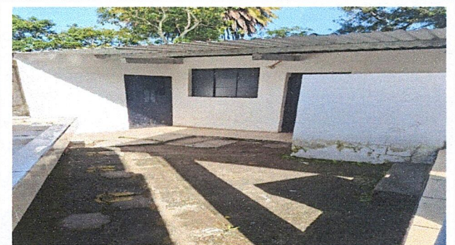
Foto 4: Reparación del corredor de la cocina.
