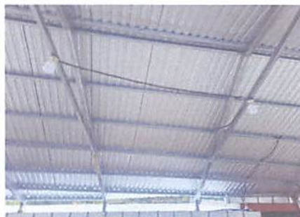
Foto 2: 36 láminas troqueladas calibre 26mm, instaladas
