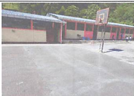
Foto 5: 80 metros cuadrados de pavimento terminado de 8"10 con 7 centímetros de grosor.
