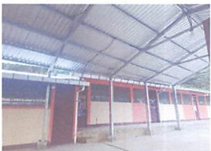
Foto 3: 14 Parales de metal de 4"8 con costaneras de 2"8 pulgadas, instaladas.
