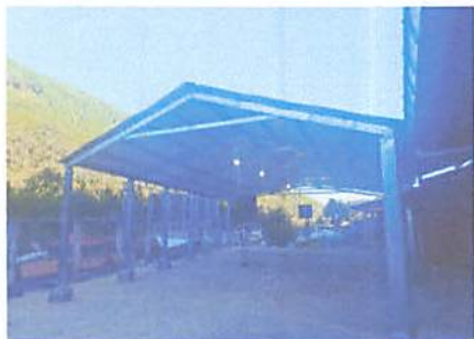
Foto1: Techado terminado, con medidas de 13 mts. de ancho por 18 mts. de largo de dos aguas.
