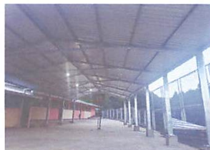
Foto 4: 20 tubos de metal de 1.5 mm 4" x 2" z180 G80 y 45 costaneras GHT 1.5 mm 4"x2" z180 G80, instaladas en la estructura del techo.
