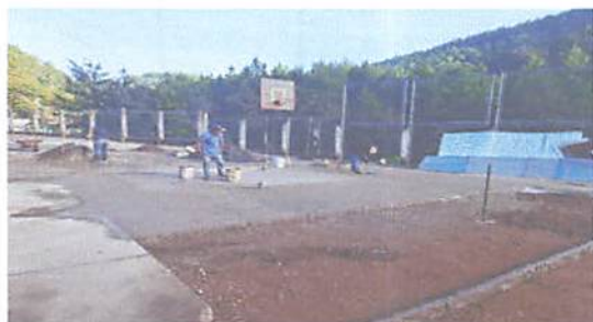
Foto 5: concluido la mitad de pavimentación de patio (8*10 con 7 centímetros de grosor)
