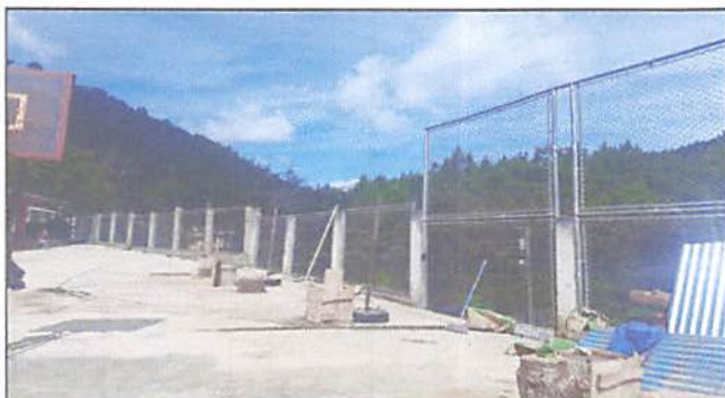
Foto 3: Fianlizan los 14 postes de concreto de base para los parales de metal.
