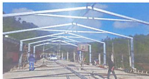
Foto 6: Terminando la instalación de 14 parales de metal de 4*8 con costaneras de 2*8. Tornillos AUTR A+5/16*2".
