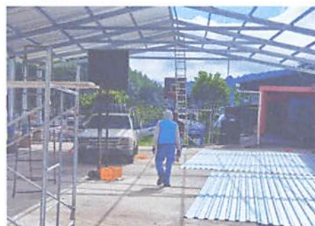
Foto 2: Ultimando las láminas por 36 láminas troqueladas calibre 26mm.
