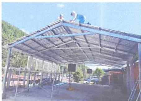
Foto 1: tejado asegurado con medidas de 13 mts. de ancho por 18 mts. de largo de dos aguas.
