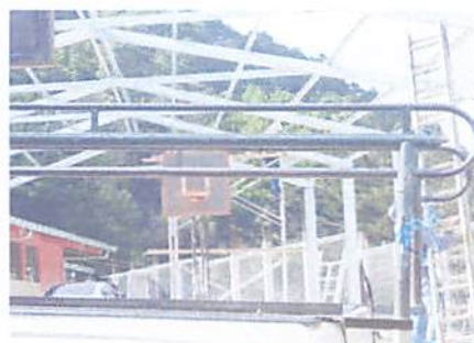
Foto 4: 20 tubos de metal de 1.5 mm 4" x 2" z180 G80 y 45 costaneras GHT 1.5 mm 4"x2" z180 G80, casi concluidas.
