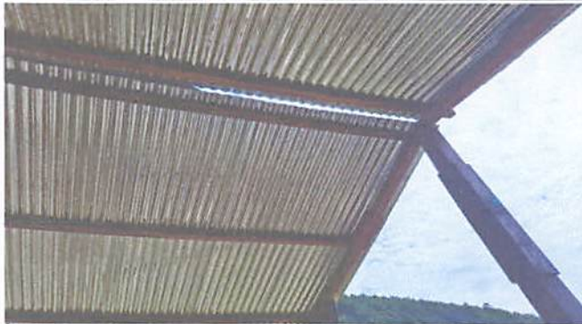
Foto 2: cambio de láminas por daños constantes de la naturaleza por 36 láminas troqueladas calibre 26mm.
