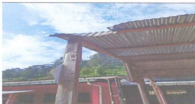
Foto 6: cambio de parales de madera por daños. Por 14 parales de metal de 4*8 con costaneras de 2*8. Tornillos AUTR A+5/16**2".
