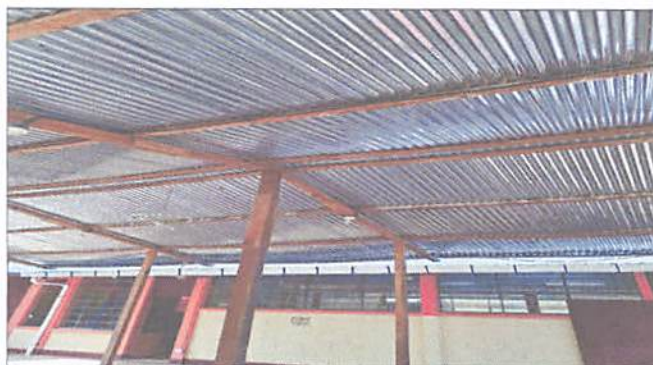
Foto 4: cambio de madera dañada por 20 tubos de metal de 1.5 mm 4" x 2" z180 G80 y 45 costaneras GHT 1.5 mm 4"x2" z180 G80
