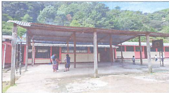
Foto 1: reemplazo de techado por daños en parales y techo por las constantes lluvias, vientos y sismos. Ya no está seguro se mueve todo. Con medidas de 13 mts. de ancho por 18 mts. de largo de dos aguas.
