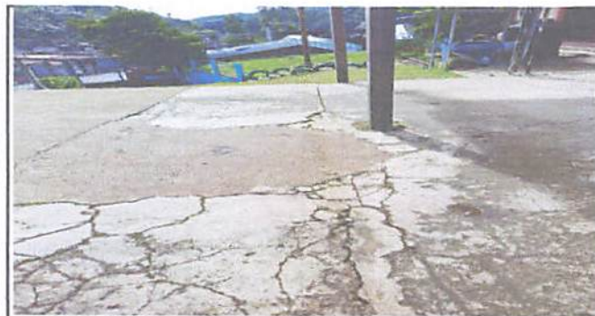
Foto 5: cambio de pavimento por daños ocasionados por fenómenos naturales. 80 metros cuadrados de patio de 8*10 con 7 centímetros de grosor.
