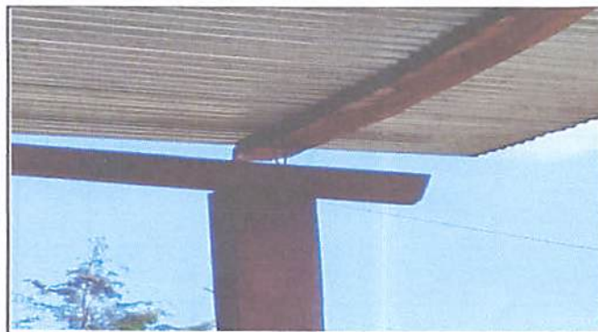
Foto 3: cambio de parales de madera dañada por 14 Postes de concreto de base para los parales de metal.
