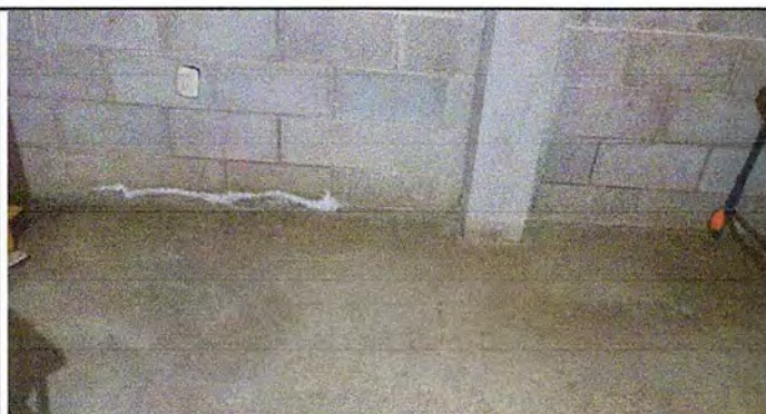
Foto 9: Construcción de isla de concreto.
