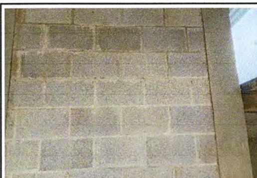
Foto 12: Perforación de pared para ventana 2
