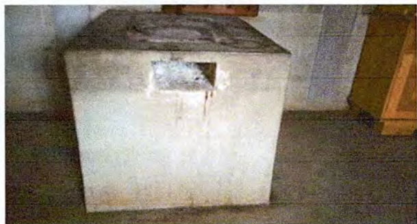
Foto 5: Colocar azulejo a la estufa de leña (poyo)
