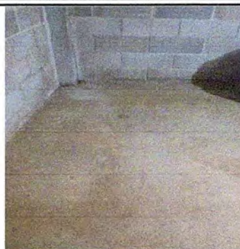
Foto 8: Construcción de una mesa de concreto.
