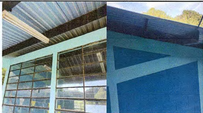
Foto 19: Sellado demoginetes en aulas.
