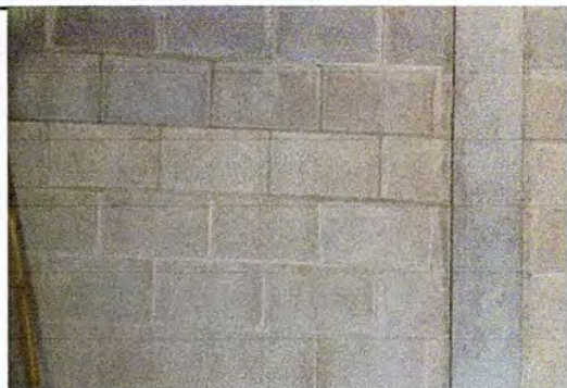
Foto 11: Perforación de pared para ventana 1
