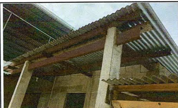
Foto 15: Instalación de canales y bajada de agua en el corredor de la cocina
