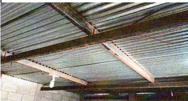
Foto 3: Cambio de techo de cocina
