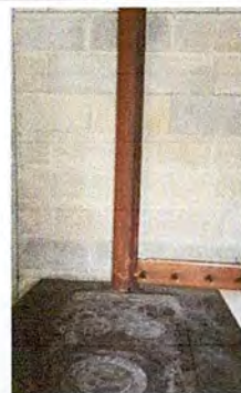
Foto 6: Cambio de chimenea (poyo)
