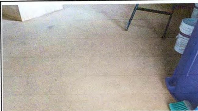
Foto 16: Instalación de piso cerámico en interior de cocina.
