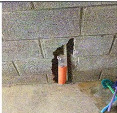
Foto 21: Instalación de lavamanos.
