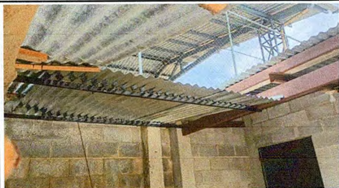
Foto 13: Instalación de canales y bajada de agua en el techo de pila
