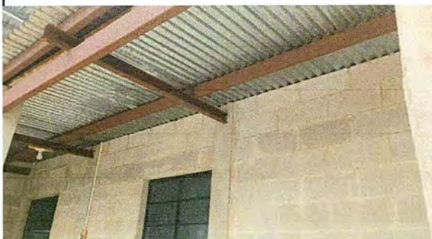
Foto 4: Cambio de techo de corredor
