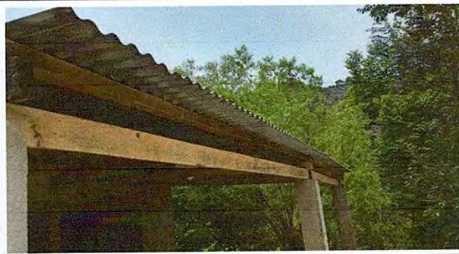
Foto 14: Instalación de canales y bajada de agua en el techo de sanitarios
