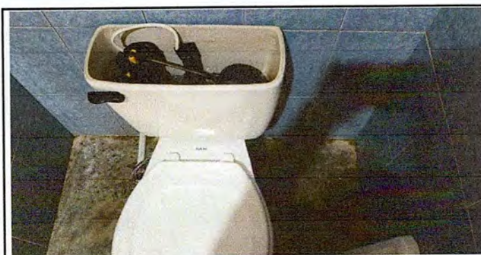
Foto 17: Cambio de sanitario 1
