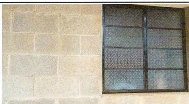
Foto 10: Ampliación de ventana, perforación y tallado de pared
