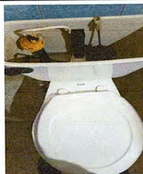
Foto 18: Cambio de sanitario 2
