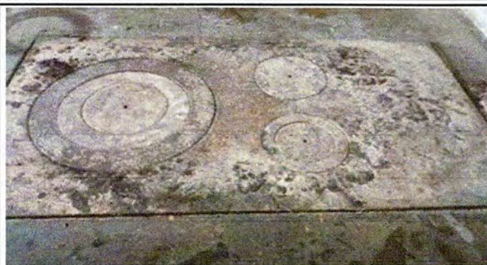
Foto 7: Cambio de plancha de estufa de leña (poyo)
