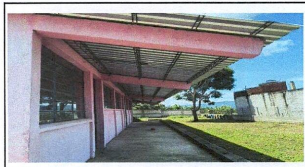
Foto 4: Instalación eléctrica pasillo 1
