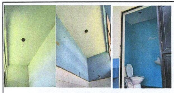
Foto 6: Instalación eléctrica sanitarios
