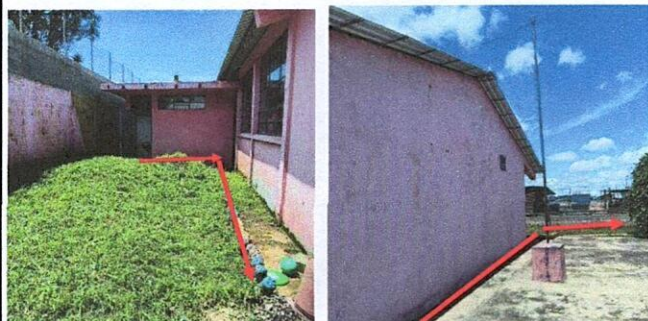
Foto 3: Reparación de drenaje
