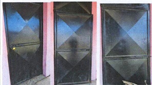
Foto 4: Enderezado, pintura, limpieza, colocación de pasadores y candados en 3 puertas
