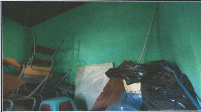
Foto 2: la parte de la pared que será quitada para la ampliación del salón.
