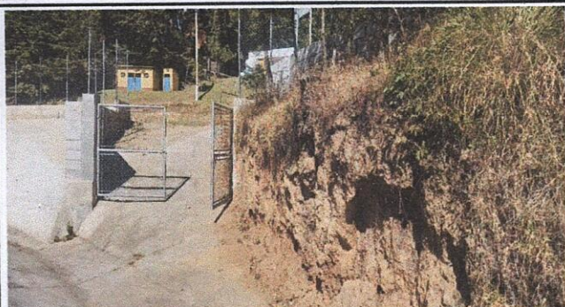
Foto 1: MURO DE CONTENCIÓN
