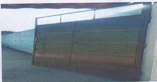
Foto 3: instalación de chapa de engrape
