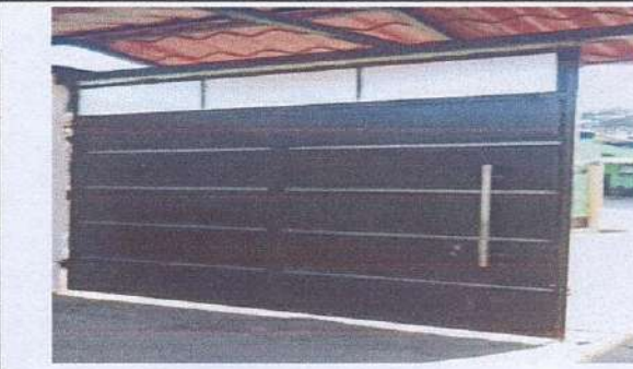
Foto 4: reparacion y pintado de portón
