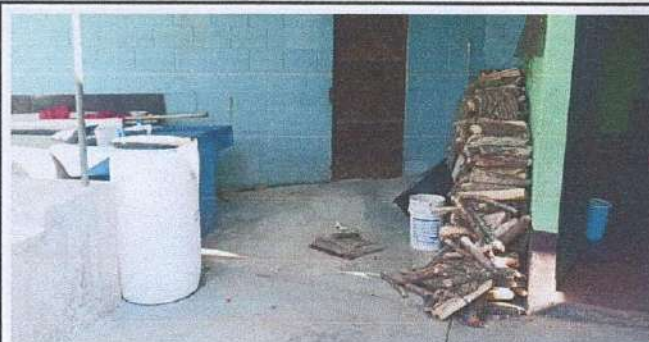
Foto 1: construcción de bases de concreto y colocación de sisternas
