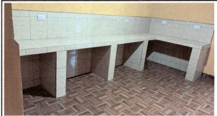
Levantado de picadero diagonal gabinete.
