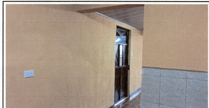
Foto 3: Repello de paredes.
