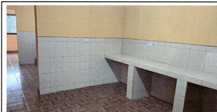
Foto 4: Remodelación y colocación de piso cerámico en los ambientes de la cocina.
