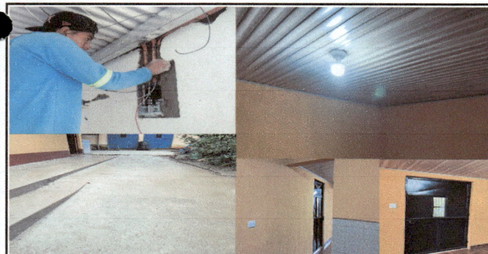
Foto 5: Instalación eléctrica, remodelación y fundición de pavimento del corredor de la cocina, demolición por apertura de puertas, colocación de puerta color negro y cierre de ventana.
