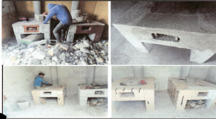
Foto1: Remodelación de hornos artesanales para cocina.
