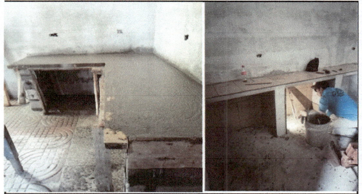
Levantado de picadero diagonal gabinete.
