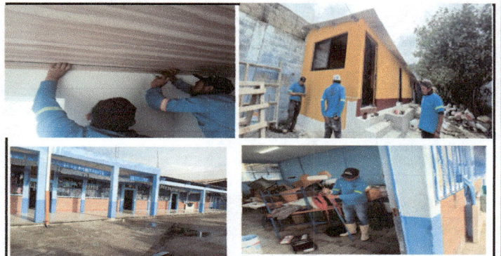
Foto 6: Instalación de cielo falso con material PVC, pintado de paredes de cocina y salones.
