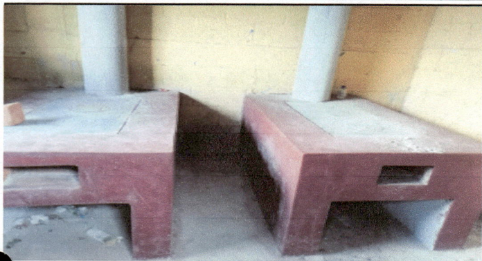
Foto 1: Remodelación de hornos artesanales para cocina, elaboración de mesa de concreto para picar verduras, colocación de piso azulejo.
