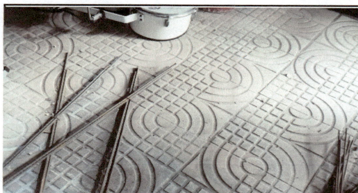
Foto 4: Remodelación y colocación de piso cerámico en los ambientes de la cocina.
