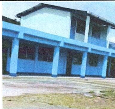
Foto 2: Sustrucción de pavimento de patio
