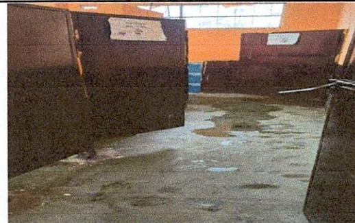
Foto 6: Renglón 6. Sustitución de piso para baño antideslizante, para evitar la acumulación de agua.
