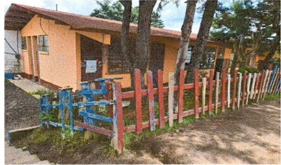
Foto 2: Renglón 7. Barandas de metal color corinto liso
