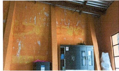
Foto 4: Renglón 5. Repello de cocina, para evitar humedad y deterioro de la pared.
