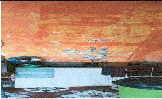
Foto 3: Renglón 5. Repello de cocina, para evitar humedad y deterioro de la pared
