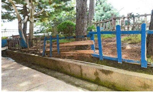
Foto1: Renglón 7. Barandas de metal color corinto liso
