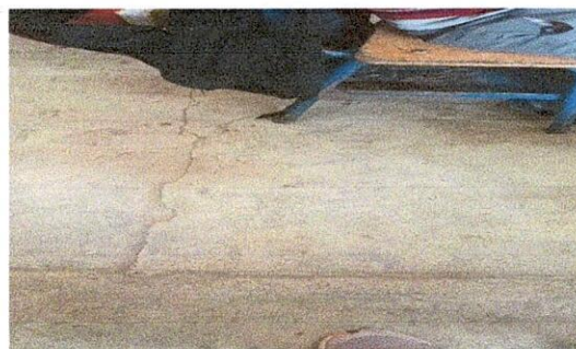
Foto 2: Renglón 1. Sustitución de piso antideslizante en aulas. Con el fin de mejorar la calidad del piso en los salones de clases.
