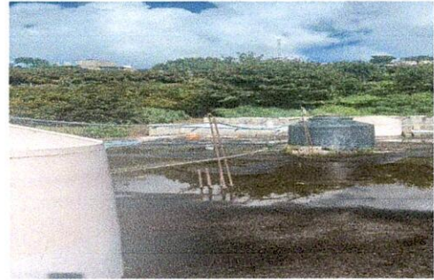
Foto 2: Renglón 4. Sustitución de tubería principal, con el fin de evitar grietas en donde están los depósitos de agua.
