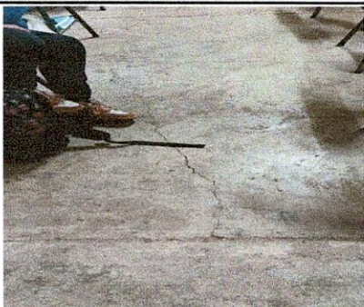
Foto 1: Renglón 1. Sustitución de piso antideslizante en aulas. Con el fin de mejorar la calidad del piso en los salones de clases.
