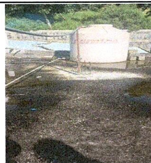
Foto 6: Renglón 3. Sustitución de depósito de agua. Para evitar contaminación del agua y desperdicio del mismo.
