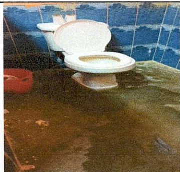
Foto 3: Renglón 2. Sustitución de sanitarios. Para mantener una higiene y el cuidado de los mismo.
