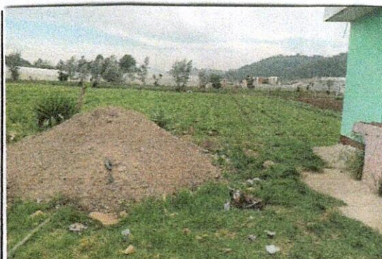
Foto 6: construcción Muro o pared
