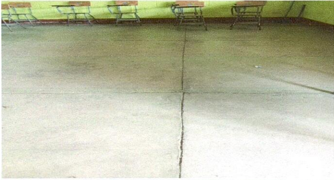
Foto 1: Limpieza y lavado de pavimento existente
