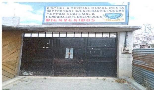
Foto 8: Reparación y mantenimiento a portón principal consistente en 2.26m de base por 2.43m de altura
