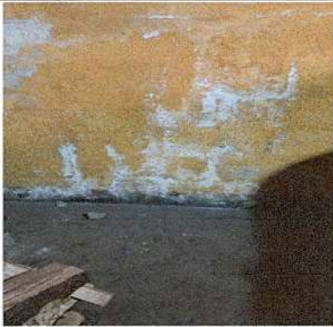
Foto 7: Se necesita elaborar 1 fogón nuevo.
