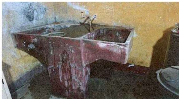
Foto 5: Se necesita reparación de drenaje e instalación de pila nueva
