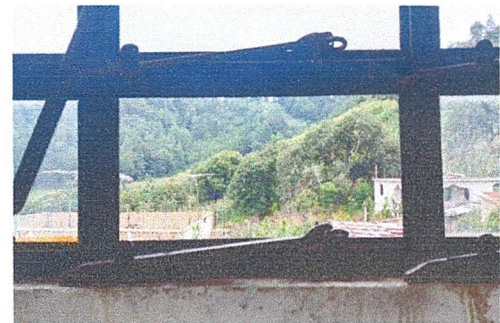
Foto 6: Colocacion de vidrios a ventanas.
