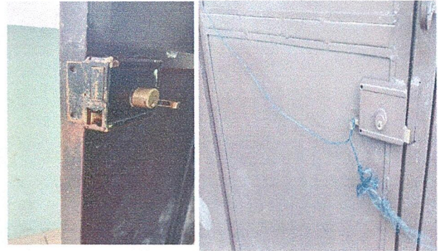
Foto 2: Cambio de chapas y pintado de puertas.
