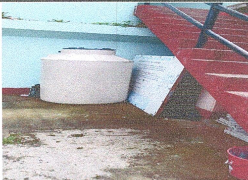
Foto 5: colocacion de tinacos en el segundo nivel con sus sistema de entubado, para abastecer los baños y la cocina.
