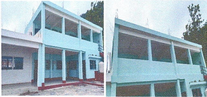
Foto1: colocar marcos de metal grandes con vidrios resistentes. Pintado interior y exterior de los salones.
