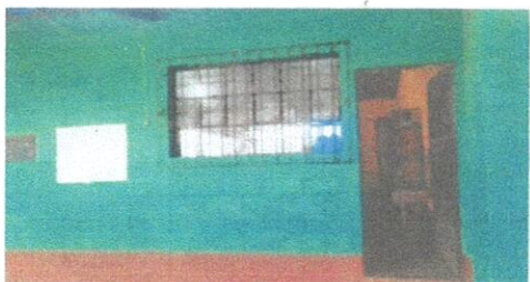
Foto1: Reparación y pintado de puerta de metal.
