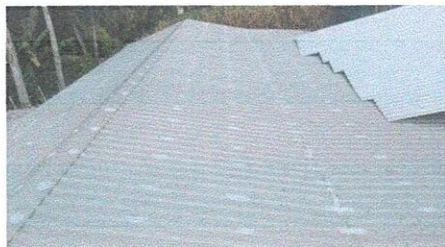
Foto 5: reparación de techo por goteras en tornillos flojos.
