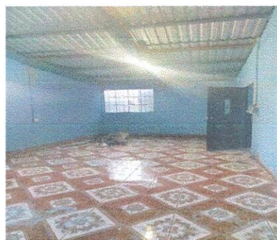
se botó esta columna que obstruye el aula y se reforzará desde las columnas
