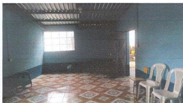
Foto 6, se botó parte de pared que no permite el trabajo en el aula, y se reforzará en laterales
