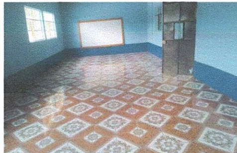
Foto 2: Se realizó cambio de piso en un aula la cual esta undida y agrietada.
