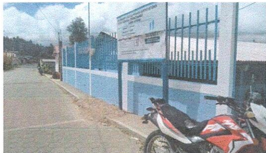
Foto 1: repintado de rejas de circulación de la fachada de la escuela
