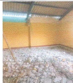
Foto 6: se boto parte de pared que no permite el trabajo en el aula, y se reforzara en laterales
