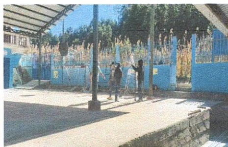
Asegurar bigas de techado.
