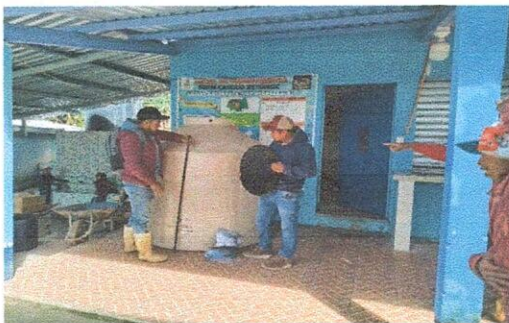
Foto 5: Se colocara un tinaco que avastece directaente a sanitarios ya que este se encuentra improvisado
