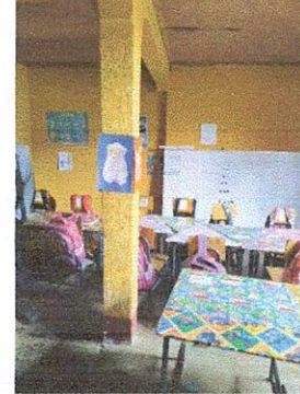
se botará esta columna que obstruye el aula y se reforzara des de columnas
