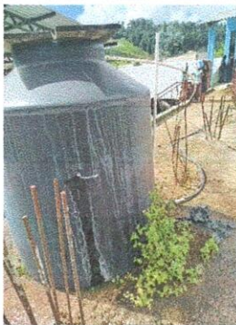
Foto 5: Se colocara un tinaco que avastece directaente a sanitarios ya que este se encuentra improvisado
