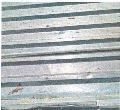
Foto 5: Reparación de techo por goteras en tornillos flojos.
