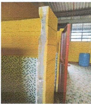
Foto 3: En los servicios sanitarios se le realizara trabajos de reforzamiento en los pines de los servicios sanitario ya que algunas puertas estan por caerse.
