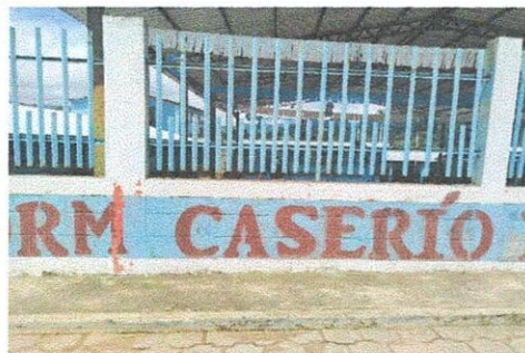
Foto 2: Pinta la fachade del establecimiento.
