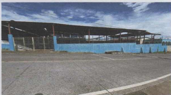
Foto 5: pintura de muro
