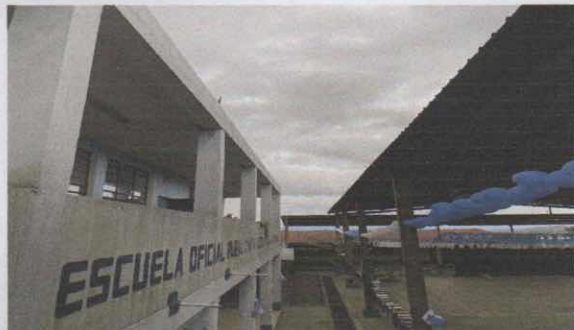
Foto 3: instalación de un canal de agua pluvial y bajada
