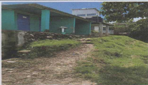
Foto1: fundición de rampa, intalación de canales de agua fluvial y bajada y levantado de muro .
