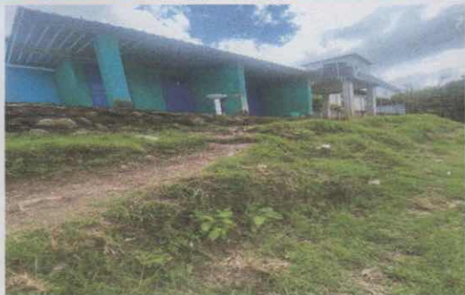
Foto1: colocación de baranda de bloque de celosía, sobre la rampa
