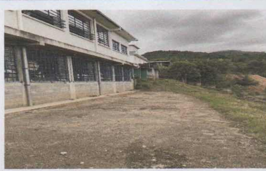
Foto 2: fundición de pavimento
