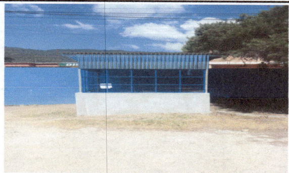
Foto 6: mejoramiento de garita en entrada principal
