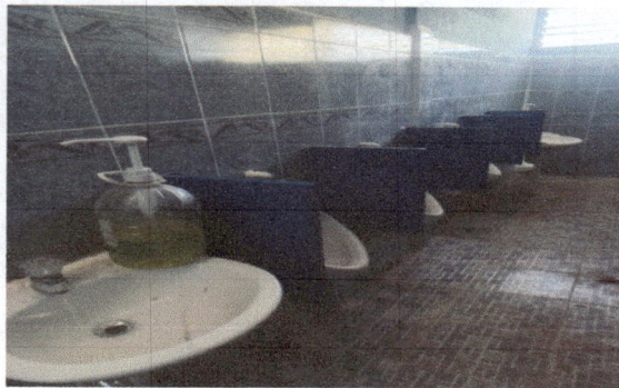
Foto 3: cambio de accesorios para mingitorios y tazas en servicios sanitarios.
