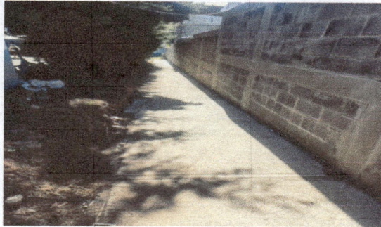
Foto1: Rehabilitación de rampa para personas con discapacidad y transporte de carga.
