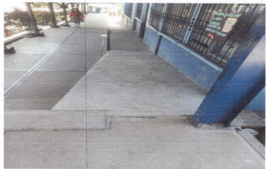
Foto 2: ampliación de rampa para personas con discapacidad y transporte de carga.
