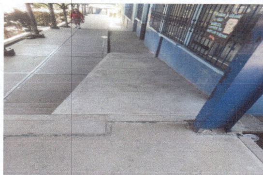
Foto 2: ampliación de rampa para personas con discapacidad y transporte de carga.
