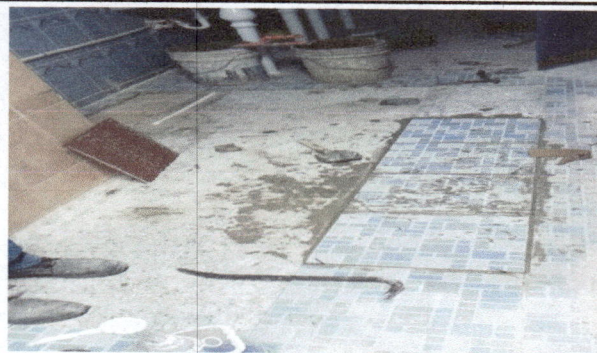
Foto 4: reposición parcial de azulejos y cerámico en servicios sanitarios.
