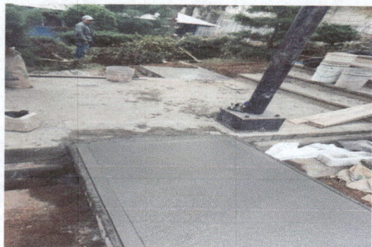
Foto1: Rehabilitación de rampa para personas con discapacidad y transporte de carga.
