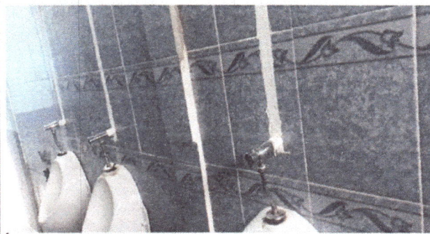
Foto 3: cambio de accesorios para mingitorios y tazas en servicios sanitarios.
