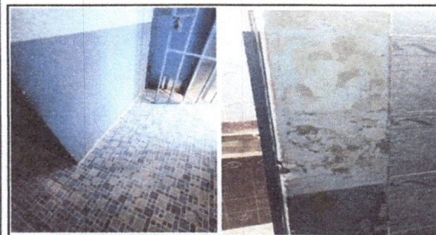
Foto 5: colocación de zócalo en servicios sanitarios y reparación de drenaje en sanitario
