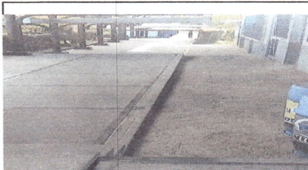
Foto 2: ampliación de rampa para personas con discapacidad y transporte de carga.
