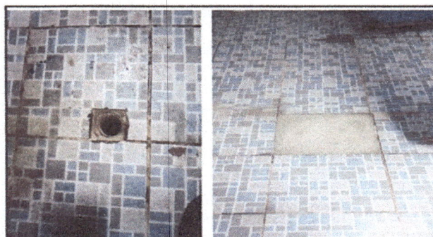
Foto 4: reposición parcial de azulejos y cerámico en servicios sanitarios.
