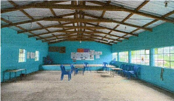
Foto1: Servicio eléctrico , salón de usos múltiples.
