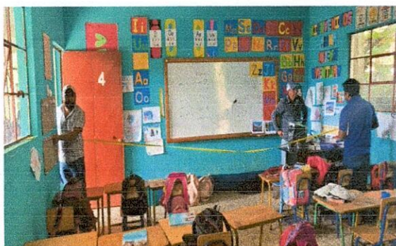
Foto 3: Reparación de sistema eléctrico, aulas primer nivel
