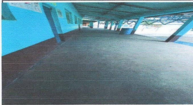
Foto1: esta fotografia muestra el corredor donde se colocara el piso.
