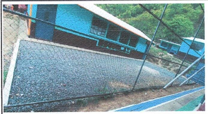
Foto 4: Losa de patio
