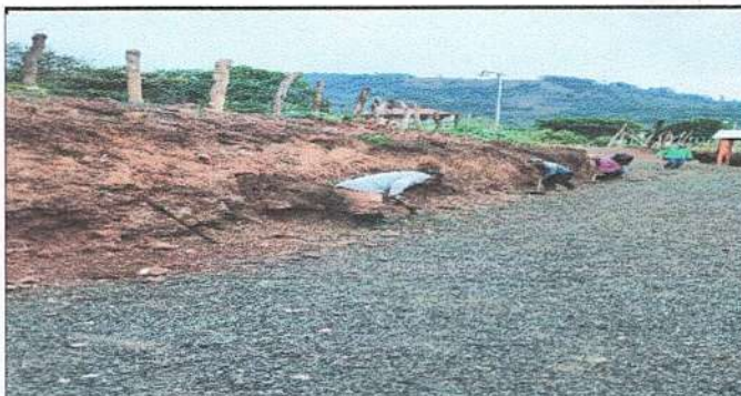
Foto 6: Preparacion del Terreno para Proteccion de Talud de un muro de contencion.
