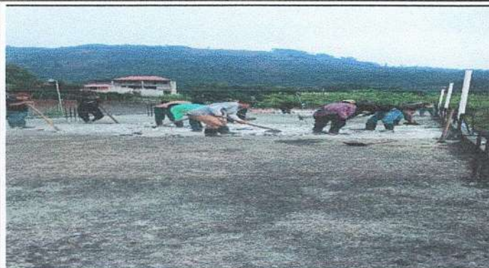
Foto 1: Limpieza para Reparacion e Impermeabilizacion de losa
