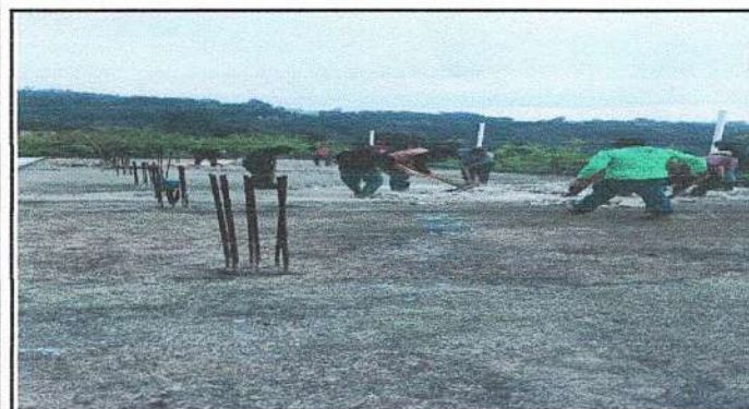
Foto 3: Limpieza para Reparacion e Impermeabilizacion de losa
