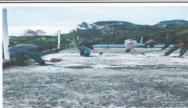
Foto 2: Limpieza para Reparacion e Impermeabilizacion de losa
