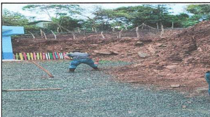
Foto 4: Preparacion del Terreno para Proteccion de Talud de un muro de contencion.
