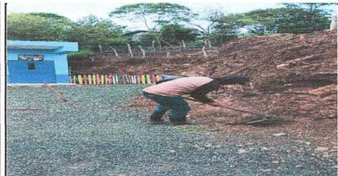
Foto 5: Preparacion del Terreno para Proteccion de Talud de un muro de contencion.
