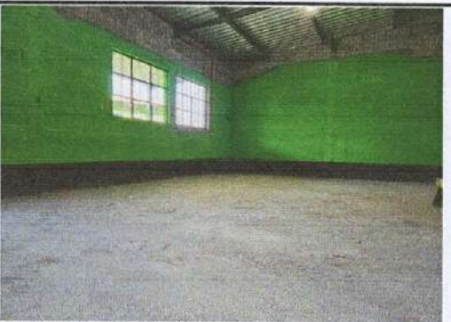
Foto 5: Se necesita instalar piso cerámico en el salón, ya que la torta de cemento acumula polvo y es difícil de limpiar.
