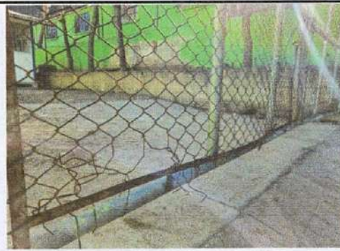
Foto 6: Se requiere cambio de malla y ampliación del portón en la parte de abajo, ya que está en alto.
