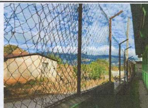
Foto 6: La malla del cerco ya no tiene estabilidad ni tensión, es necesario colocar tubos galvanizados en la parte superior del cerco.
