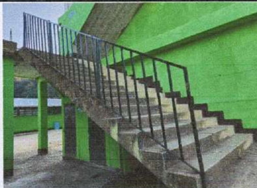
Foto 2: La baranda no presenta estabilidad ni firmeza, los hierros sujetadores son muy delgados.
