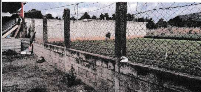
Foto 1: Parte del muro perimetral que se debe trabajar.
