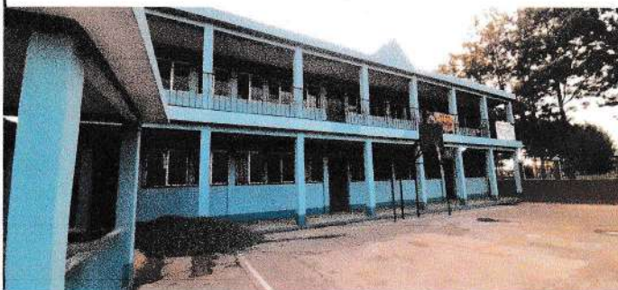
Foto 4: Bloque 1 de aulas de la escuela donde se dará el servicio eléctrico.
