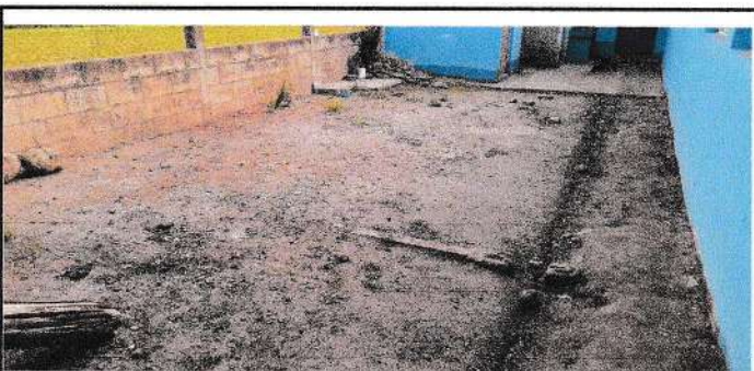
Foto 5: Actualmente esta en malas condiciones y sin uso,
