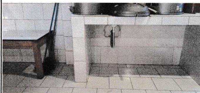
Foto 2: Espacio donde se trabajará la pila dentro de la cocina de la escuela.
