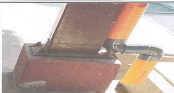
Foto1: tubo y codos nuevos para bajada de agua.
