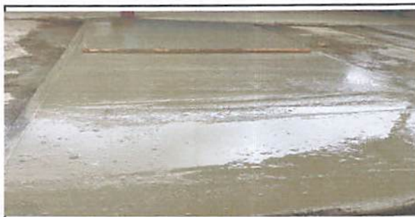
Foto 5: fundición de planchas de concreto
