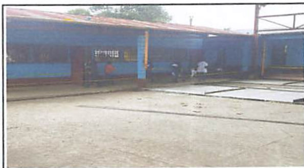
Foto 3: fundición de planchas de concreto
