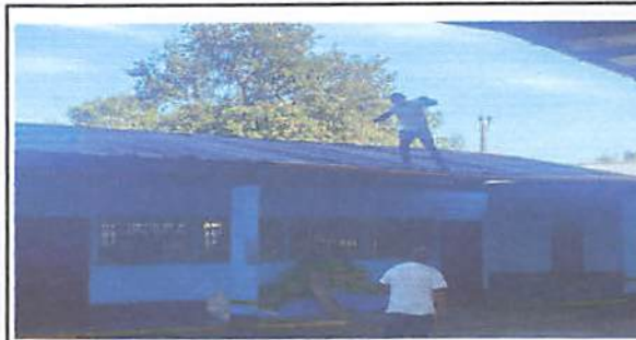
Foto 6: Sustitución de tubos de bajada de agua.
