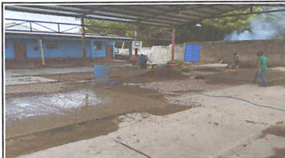
Foto 4: fundición de planchas de concreto
