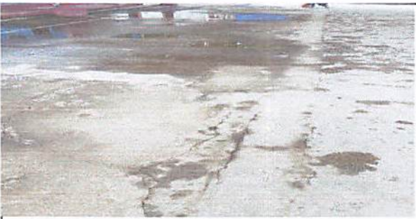
Foto 5: Reparación de plancha de concreto de cancha
