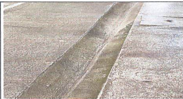
Foto 3: Reparación de cuneta de concreto
