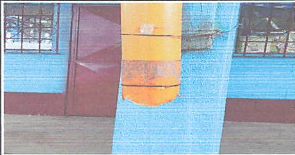
Foto1: Reparación de bajada de agua pluvial
