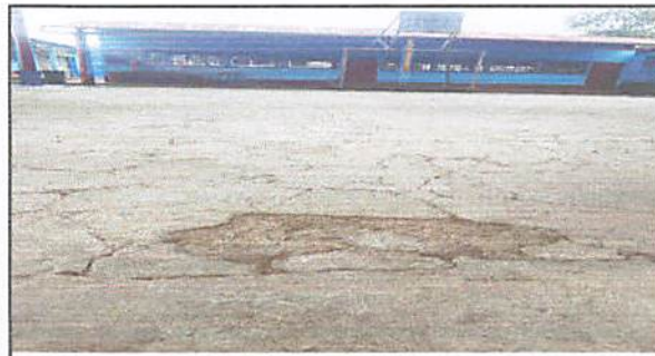
Foto 4: reparación de plancha de concreto de cancha
