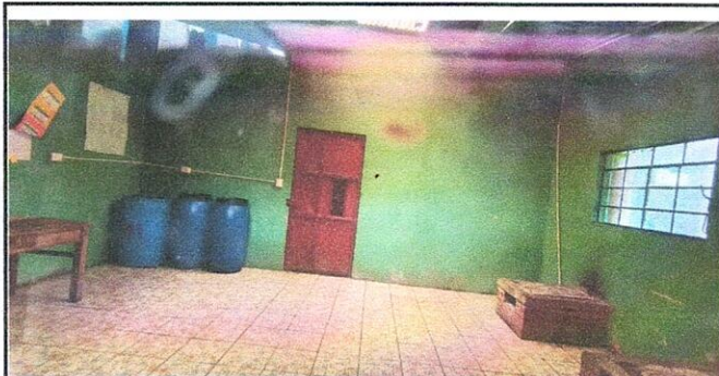
Foto 3: Reparación de área de cocina, lavatraste de concreto.
