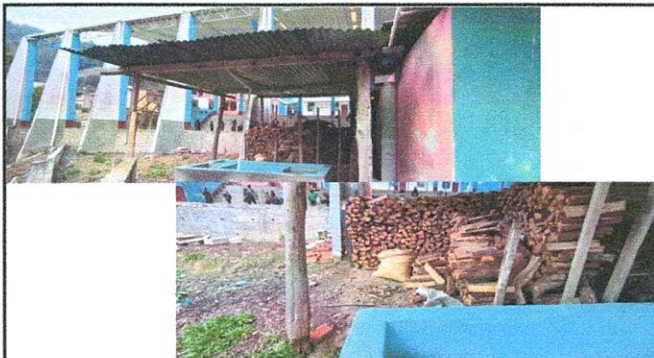
Foto 4: Reparación de área de cocina: Cambio de lamina y colocación de estructura metálica, base de concreto para emparejamiento de piso.
