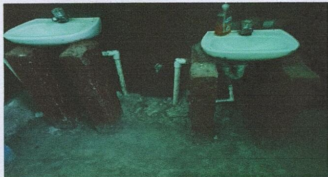
Foto 1: Reparación de lavamanos en sanitario de mujeres
