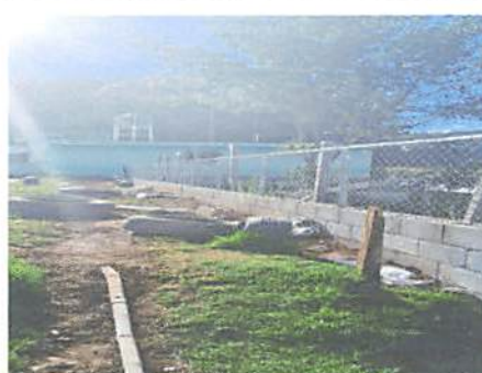
Foto 6: Muro protector de Talud
