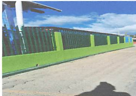
Foto 4: Area de adentro pintar paredes y aulas
