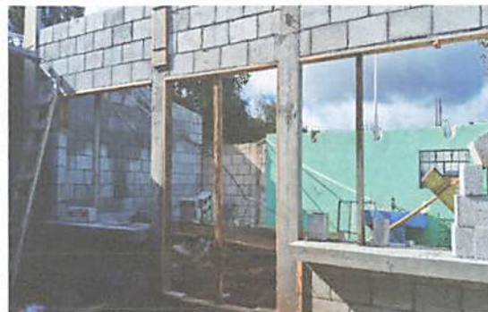
Foto 2: cocina cambiar el piso y corredor cambio de laminas
