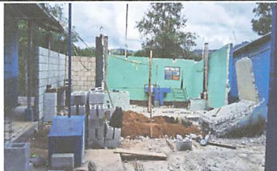
Foto 2: cocina cambiar el piso y corredor cambio de laminas
