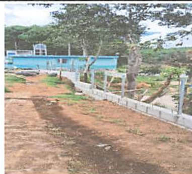
Foto 6: Muro protector de Talud
